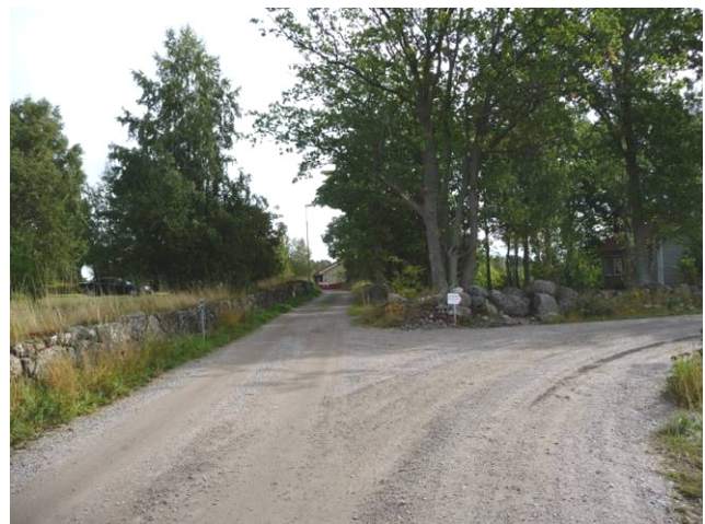
Skarpatorpsvägen vid avtagsvägen mot nytt bebyggelseområde Åmunnen
